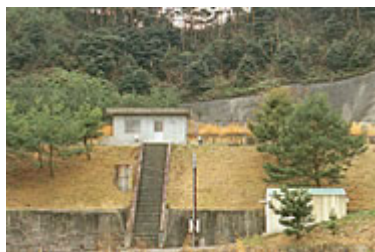
丸亀第 1 配水池
