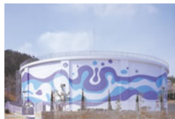
丸亀第 2 配水池
