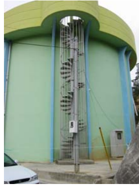
南部高区配水池
