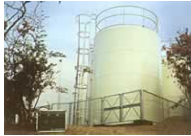
本島町小阪配水池
