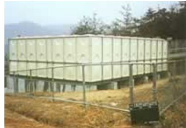
広島町江の浦配水池
