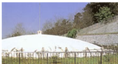
青ノ山配水池
