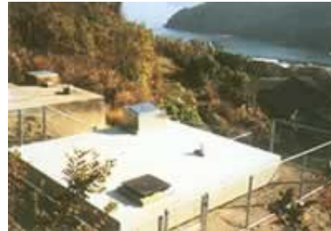
手島町配水池
